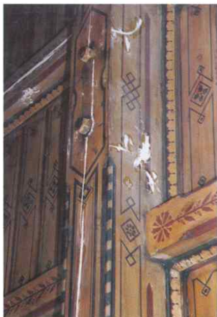
Aula w trakcie renowacji: okrywki na ścianach, stan zachowania gzymsu wieńczącego oraz fragment po uzupełnieniu ubytków drewna i pęknięć.
