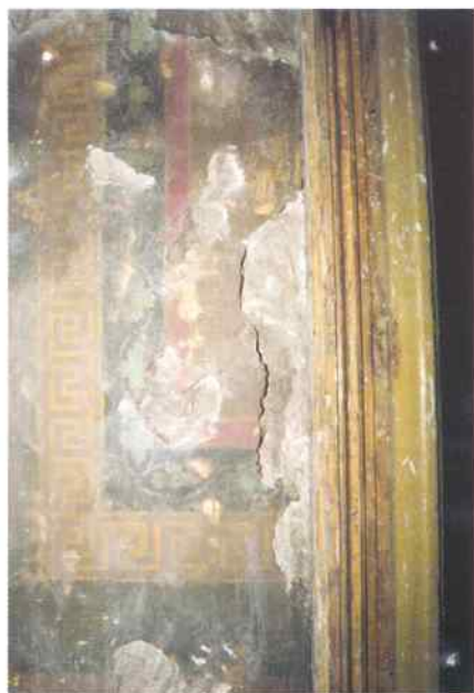
Aula w trakcie renowacji: okrywki na ścianach, stan zachowania gzymsu wieńczącego oraz fragment po uzupełnieniu ubytków drewna i pęknięć.
